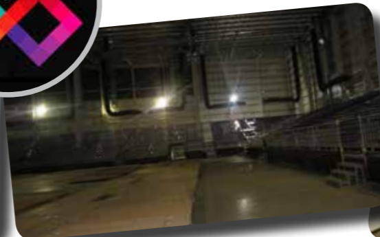
Vista interior, con 20 metros de altura
